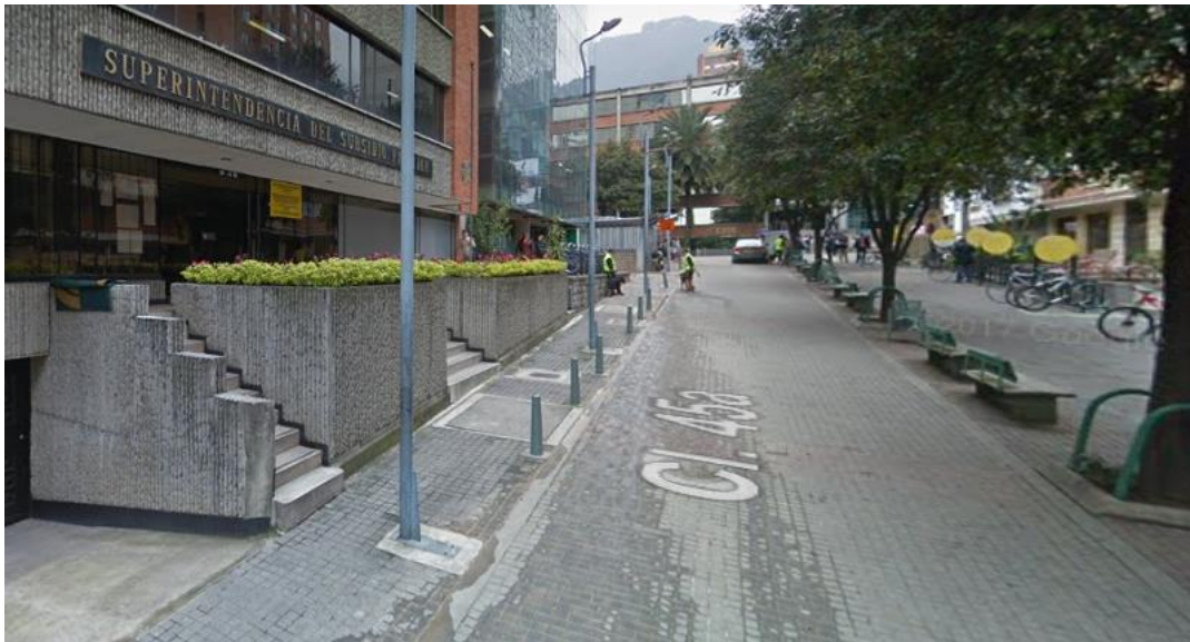
Zona de ingreso y salida de peatones Sede en remodelación.
