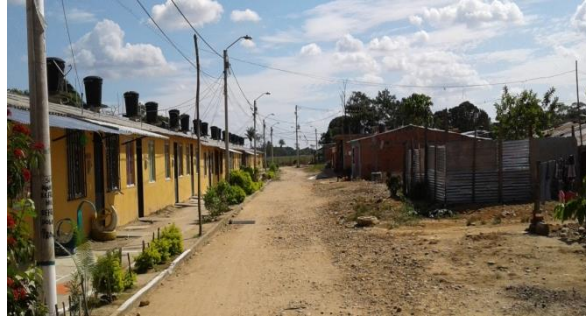
Foto 13 Vivienda rural del Departamento
